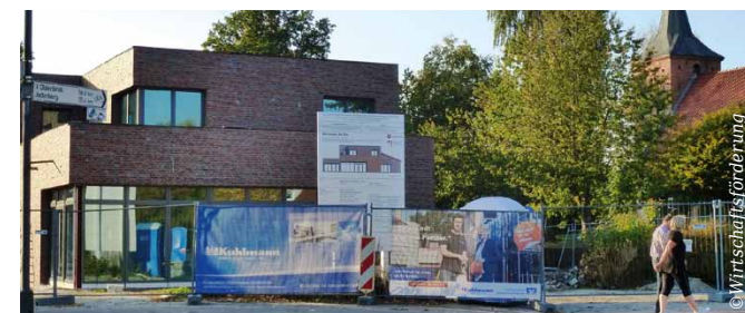
Der neue Gasthof ist noch ein Rohbau, geplante Eröffnung Frühjahr 2019.
