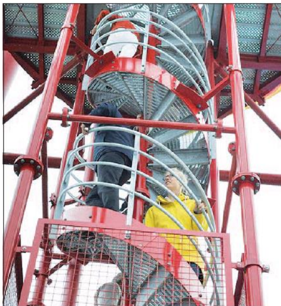
Im August 2017 wurde das Leader-Projekt „Oberfeuer Preußeneck“ in Eckwarderhörne eingeweiht. Dort wurde im ehemaligen Maschinenhaus ein Dokumentationszentrum eingerichtet und der Turm (Bild) wurde renoviert und mit Aussichtsplattformen ausgestattet.
