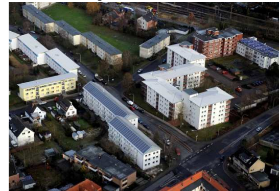
Abbildung 4: Sanierte Bestände im Geschosswohnungsbau Bremerhavens
