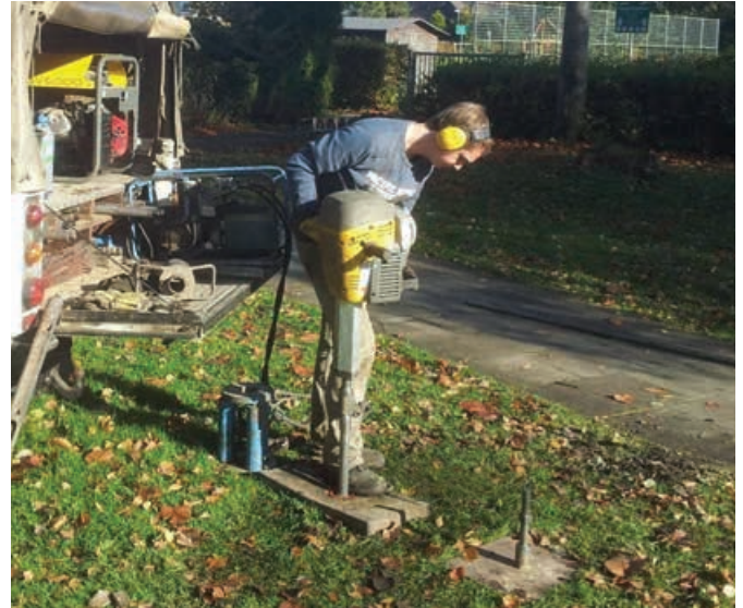
Kleinrammbohrung am Straßenrand
