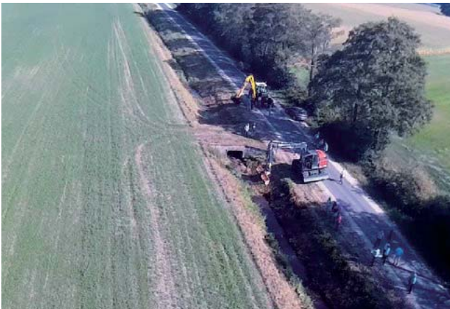
Dokumentation artenschonender Gewässerunterhaltung. Der Schlegelmäher mäht die obere Böschung, der Mähkorb krautet die Sohle und belässt einen Saum an der Wasserwechselzone. (Foto: U.A.N.)
