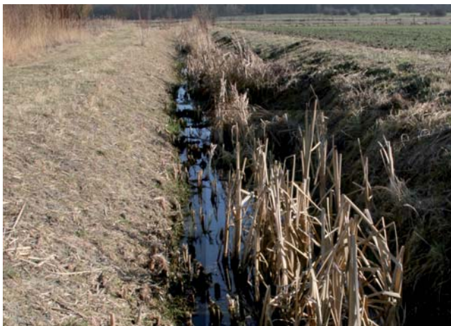
Bei alleiniger Böschungsmahd wird insbesondere der Mittelwasser-Abfluss beeinflusst. Bei hohen Abflüssen sorgt die freie Böschungsschulter für hohe hydraulische Leistung. (Foto: U.A.N.)
